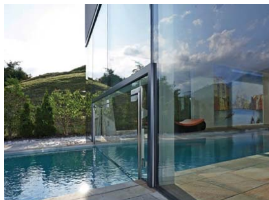
Abb. 24: Schiebetüren unter Wasser ins Ausschwimmbecken
