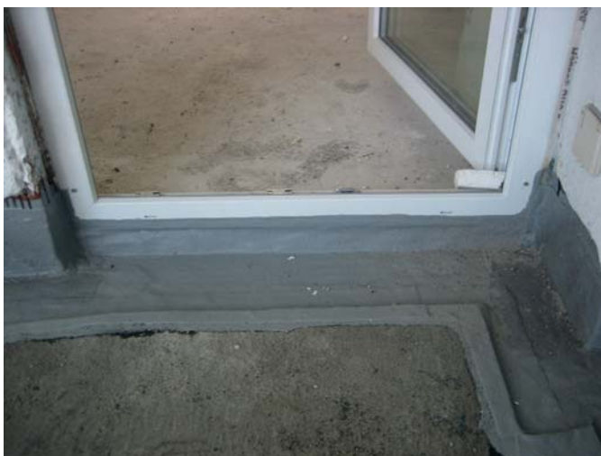
Abb. 19: Abdichtung an einem Fenster über einem Flachdach
