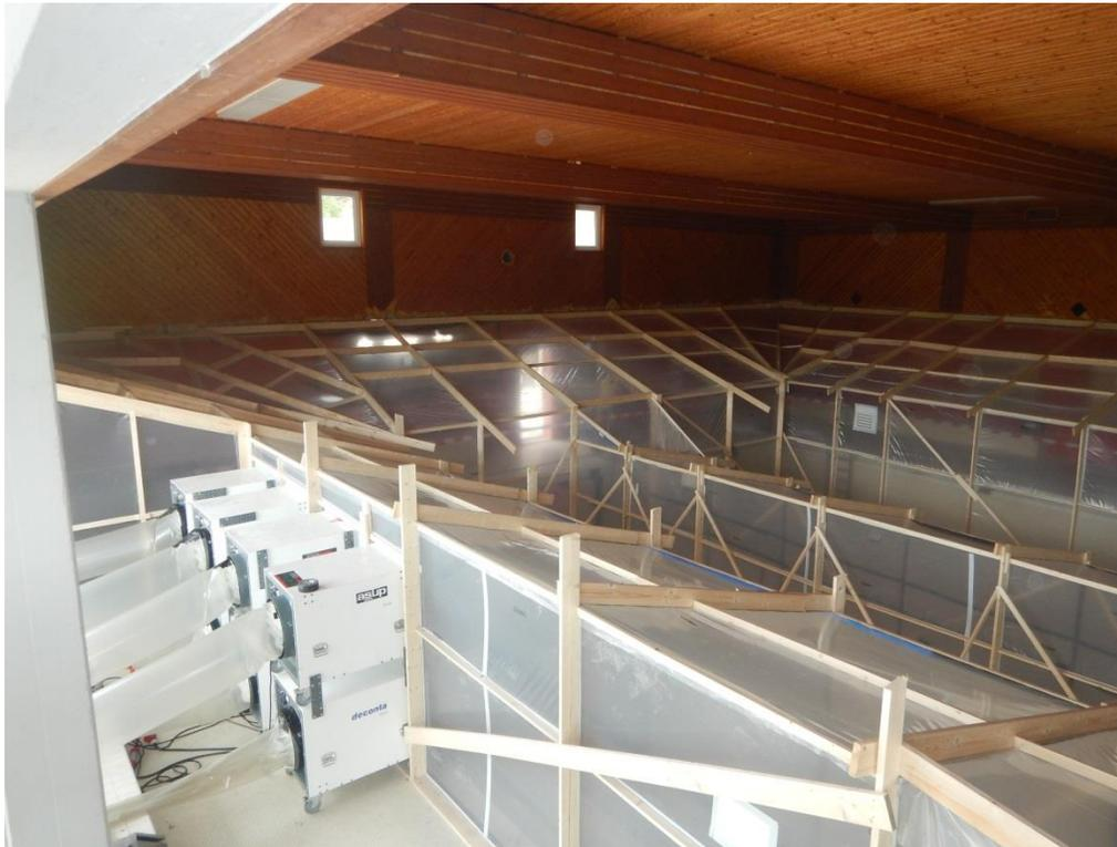
**Unterdruck-Sanierungszone für Asbestsanierung eines Aussenschwimmbekens (für Rückbau)**
